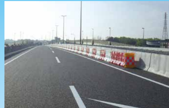
車線絞り込み
